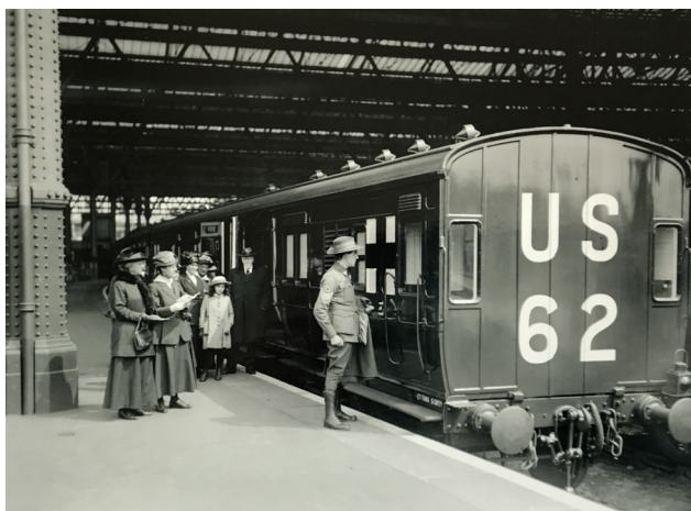
Lazarettzug des ARC in der Waterloo Station, London
