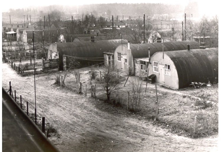
Nissenhütten im Stadtpark
