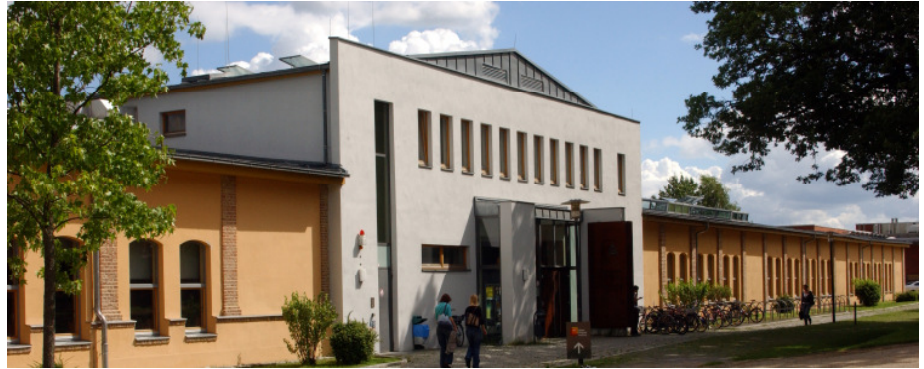
Früheres Zentraldepot (gelbe Gebäude), heute Universitätsbibliothek Potsdam in Babelsberg
