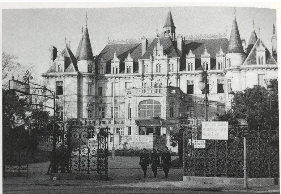
54 Außenansicht des Soldatenheims in Arcachon, Bordeaux (Südwestfrankreich), Januar 1943
